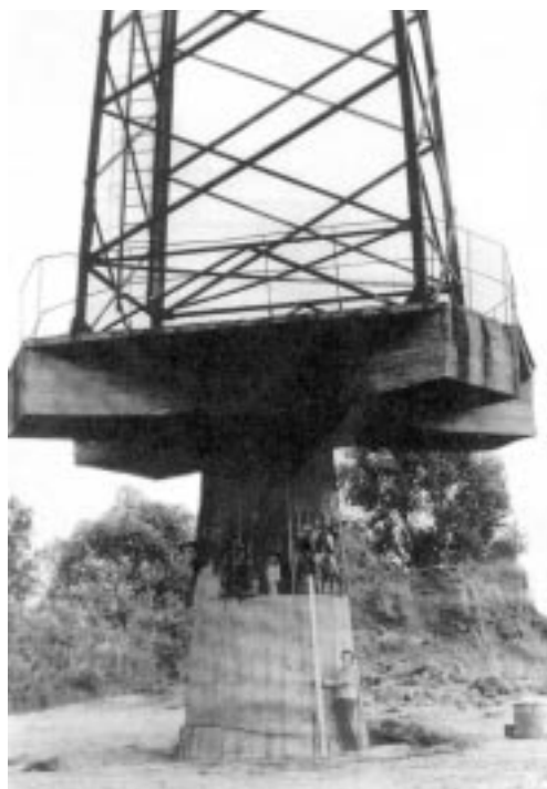
Рис. 1. Опора линии электропередач на правобережной пойме р. Оби, находящаяся в аварийном состоянии из-за размыва берега. Фото В.Н. Дьячкова
